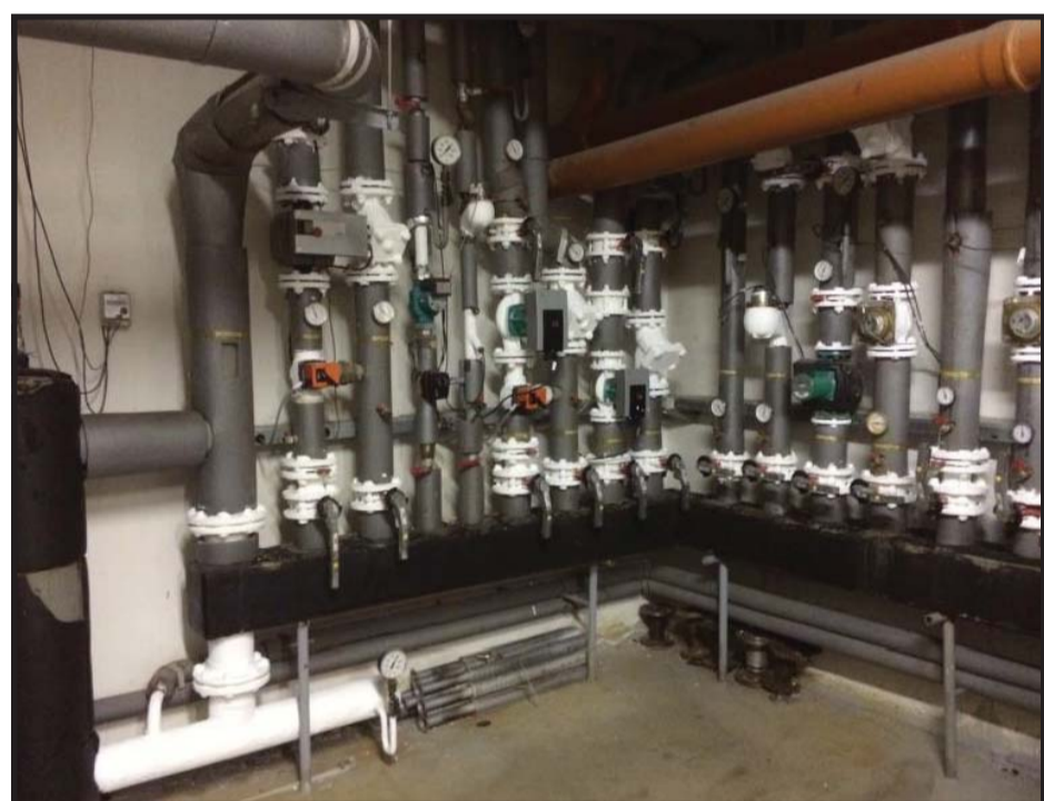
Zateplení armatur novodobou izolací Zdroj: fotodokumentace Aditex s.r.o.
