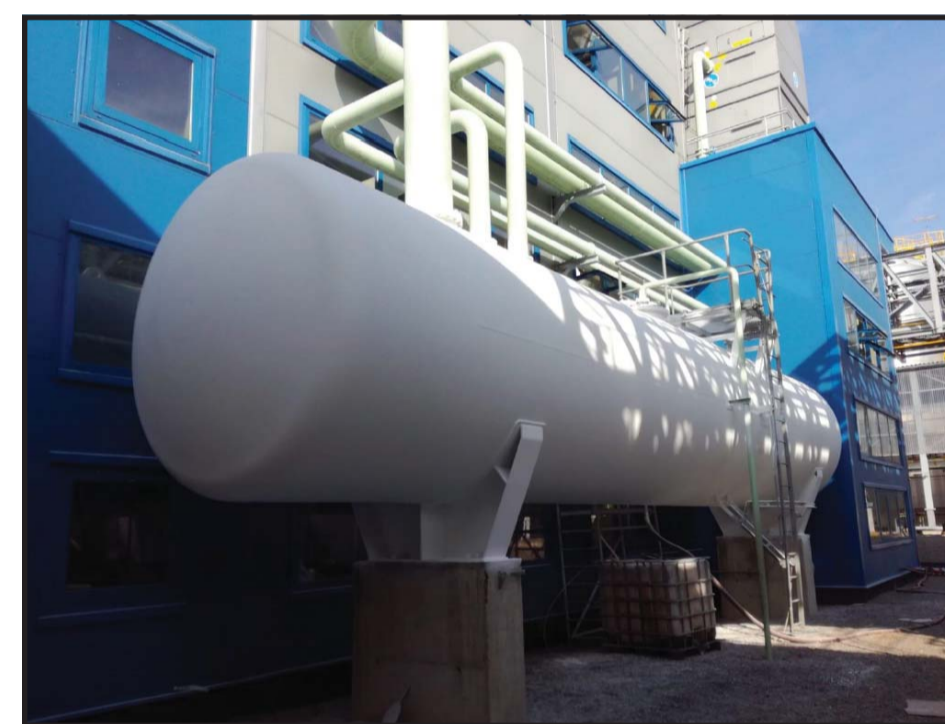
Zateplená nádrž na vodu (chemický průmysl) Zdroj: fotodokumentace Aditex s.r.o.
