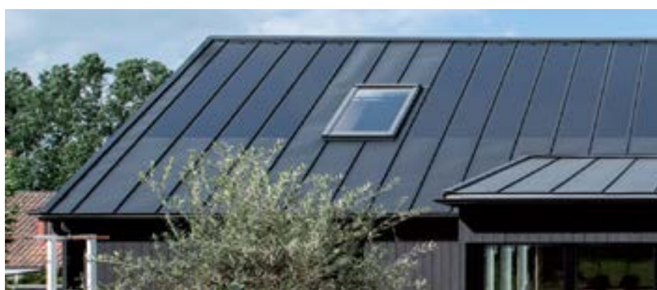
Lindab Solar Roof - s integrovanými solárními panely Zdroj: www.lindabstrechy.cz/lindab-solar-roof
