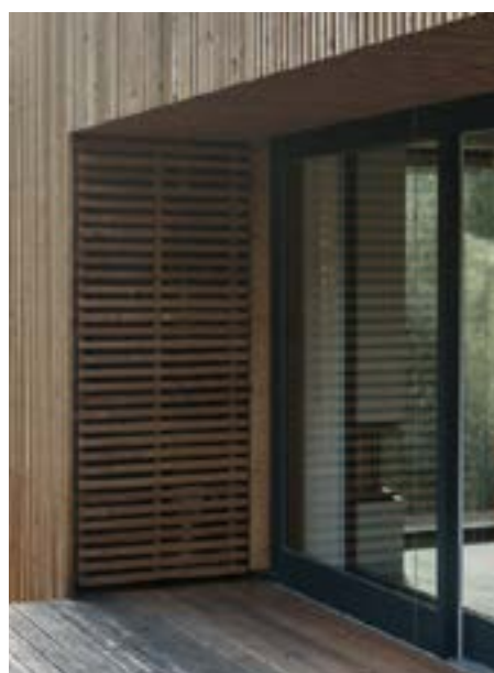
obvodová stěna dřevěná konstrukce + TI difuzně otevřená větrověsná folie větraná vzduchová mezera pohledová fasáda - dřevěný obklad
